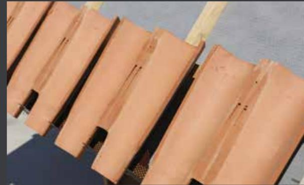
2. Agganciare la prima fila di BICOPPO® al primo listello, adagiandola nella sella della griglia di partenza, che garantirà l'ingresso di aria nel sottomanto bloccando nel contempo insetti e volatili. *Install the first line of BICOPPO® in accordance to the bird-stop on the eave; so air can move on but in the same time insects and birds are stopped*
